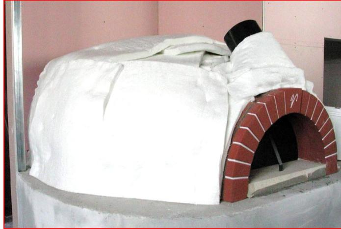
13) APRES AVOIR TERMINE LE SCELLAGE DES VOUTES, RECOUVRIR LE FOUR AVEC UNE DOUBLE COUCHE DE FIBRE CERAMIQUE ÉCOLOGIQUE CERTIFIÉE (fournie avec le kit d'isolation).
