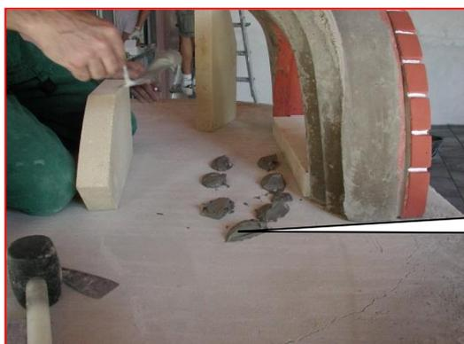
5) UTILISER JUSQU'À 3 MM DE L'ÉPAISSEUR DE MORTIER PRÉPARÉ VALORIANI VALPLAST POUR COMPENSER LES IRRÉGULARITÉS DE L'ISOLATION DU PLANCHER
